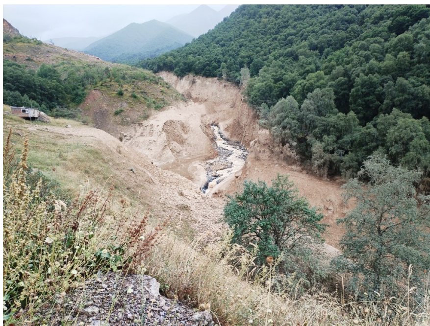
Рис. 8. Нижний участок оползня Бузулган и состояние русла р. Герхожансу на 08.2025 г. (фото Х. Ю. Гузиева)
