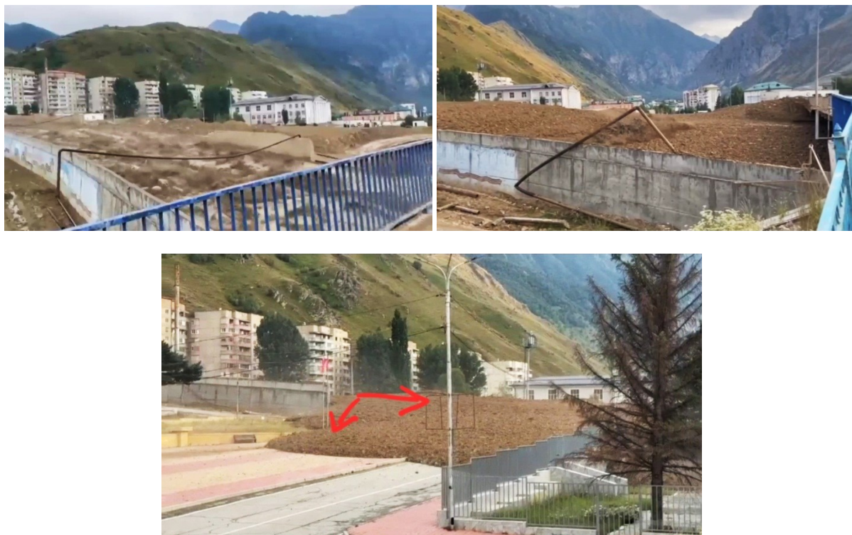
Рис. 6. Заполнение селевой массой, разрушение водопроводной трубы и частичное обрушение правого борта селепропускного лотка в бассейне р. Герхожансу 31.07.2025 г. Fig. 6. Mudflow filling, destruction of a water pipe and partial collapse of the right side of a mudflow chute in the Gerkhozhansu River basin on July 31, 2025
