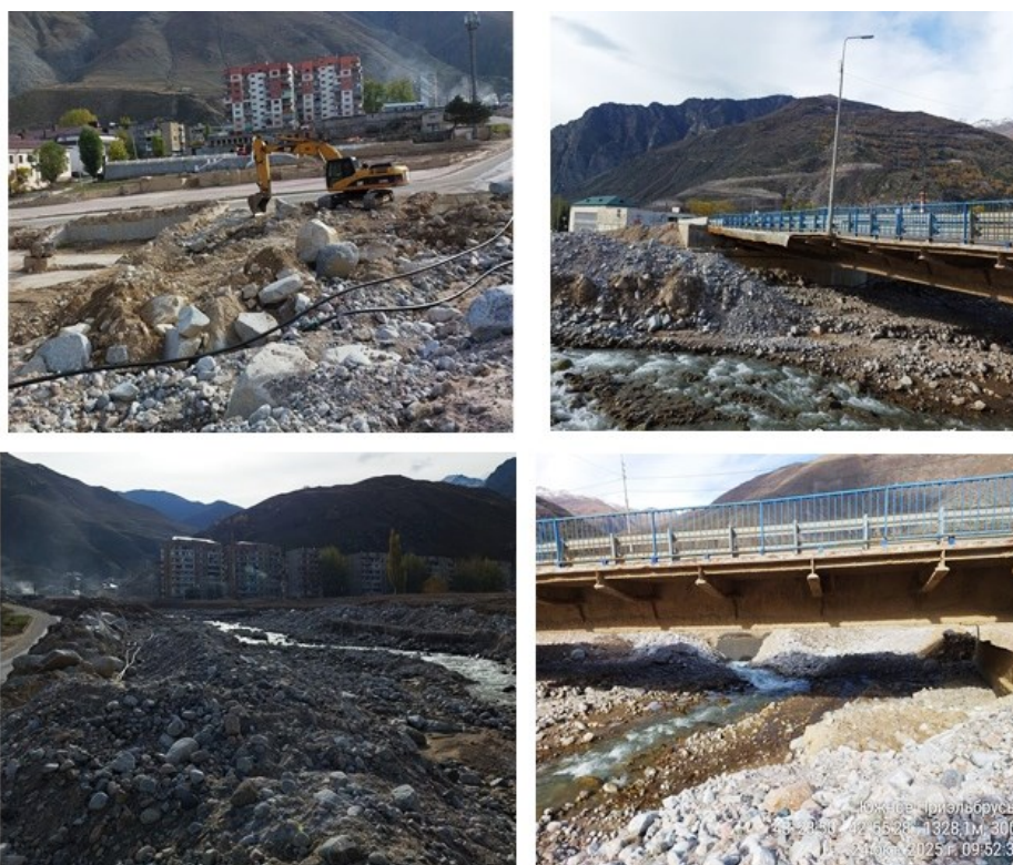
Рис. 7. Селевые отложения и состояние селепропускного лотка в бассейне р. Герхожансу на 24.10.2025 г. (фото М. М. Гедуевой)
