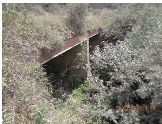
Рис. 3. Устье реки, мост автодороги (фото ВГИ) Fig. 3. The mouth of the river, the bridge of the highway (HGI photo)
