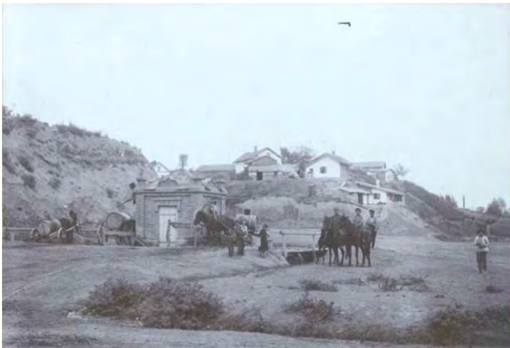
Рис. 3. Артезианский колодец и три конные повозки с бочками для перевозки воды.
